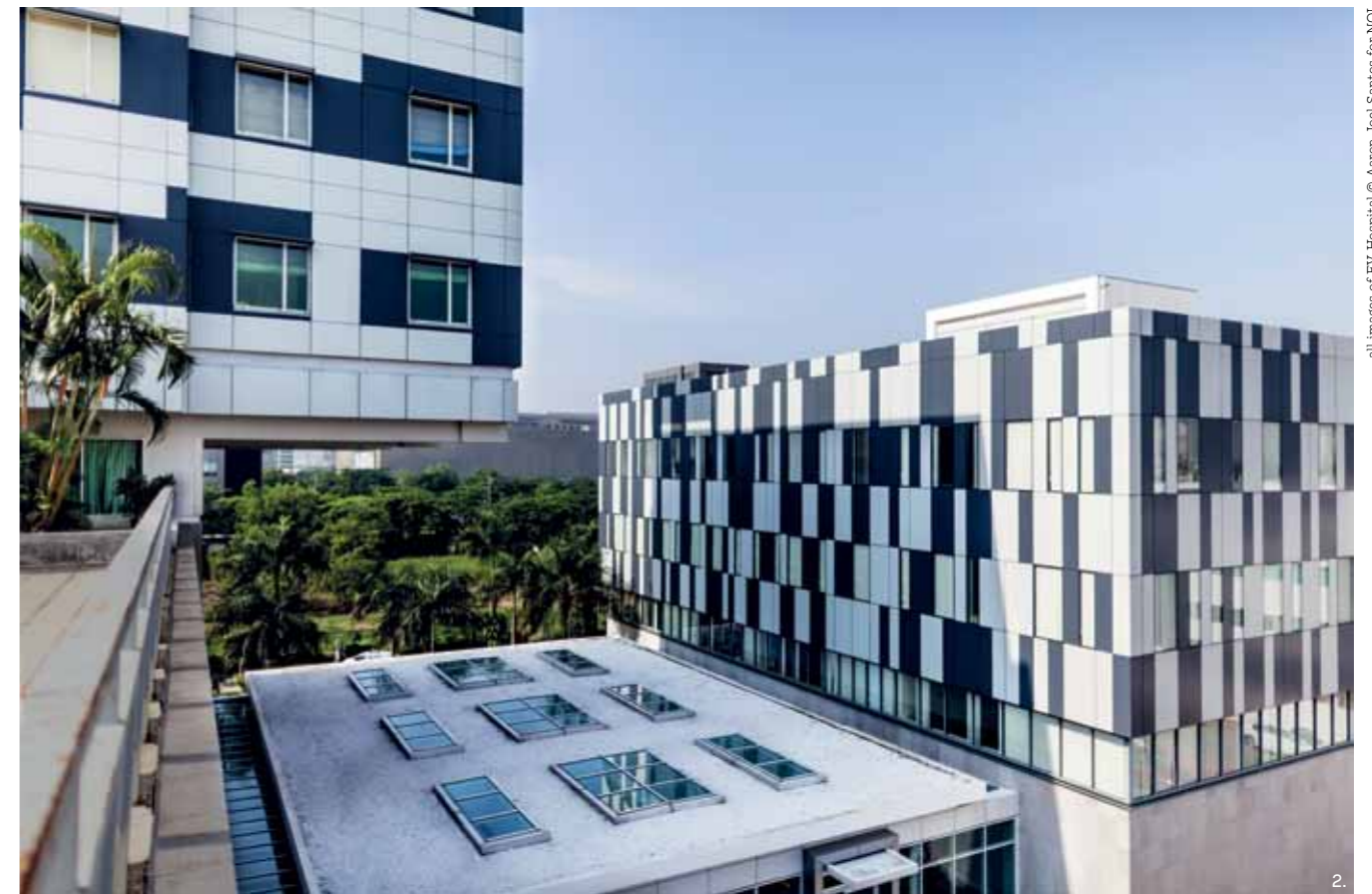
1 — Façade du bâtiment V / Facade of building V
